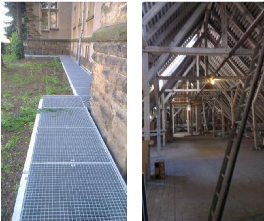
Abb. 26: L-Profilen zur Sockeldämmung an der Westseite (links) und Spitzboden (rechts)
